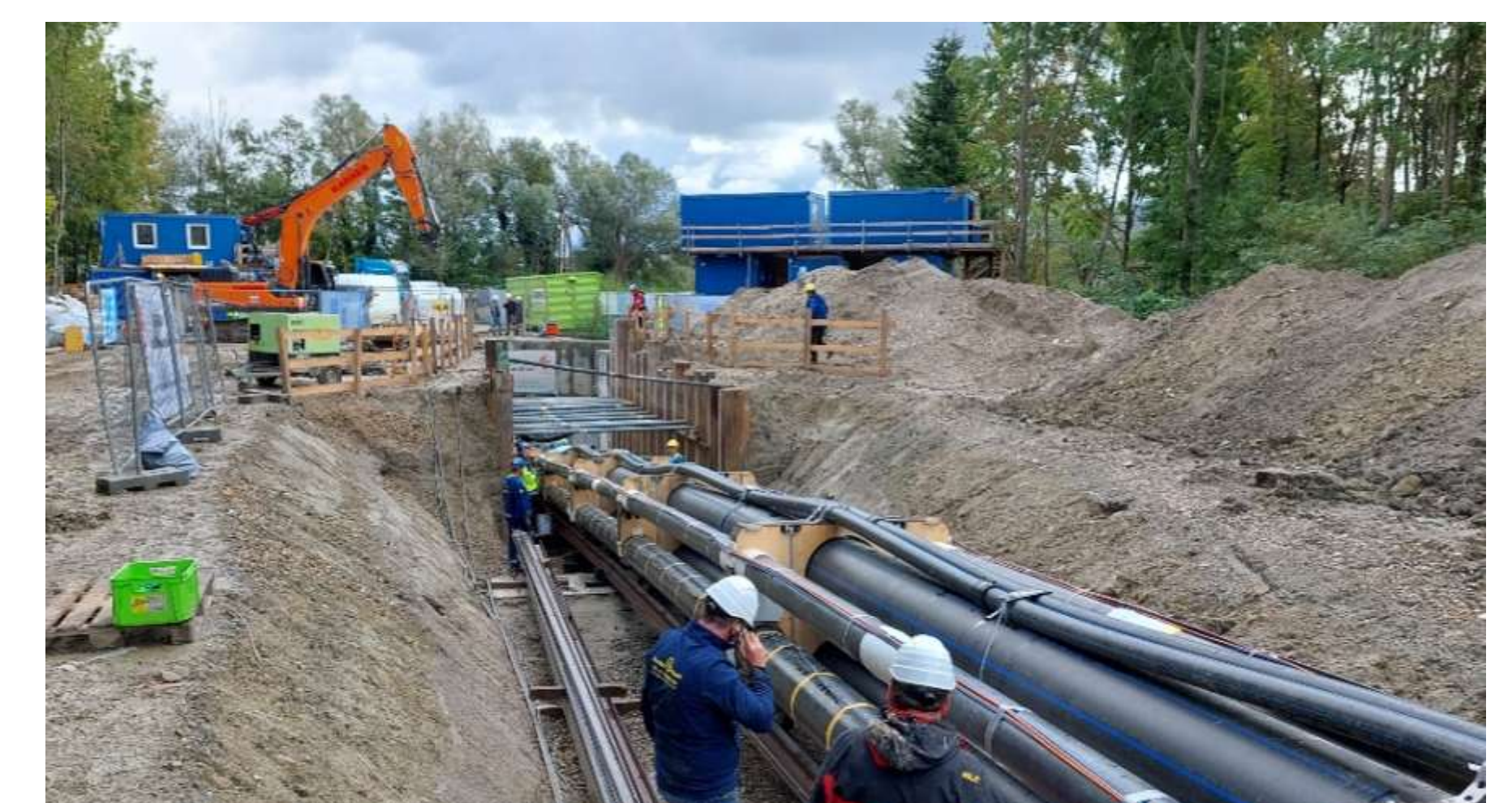
... und über ein Schienensystem in den Tunnel eingefahren.
