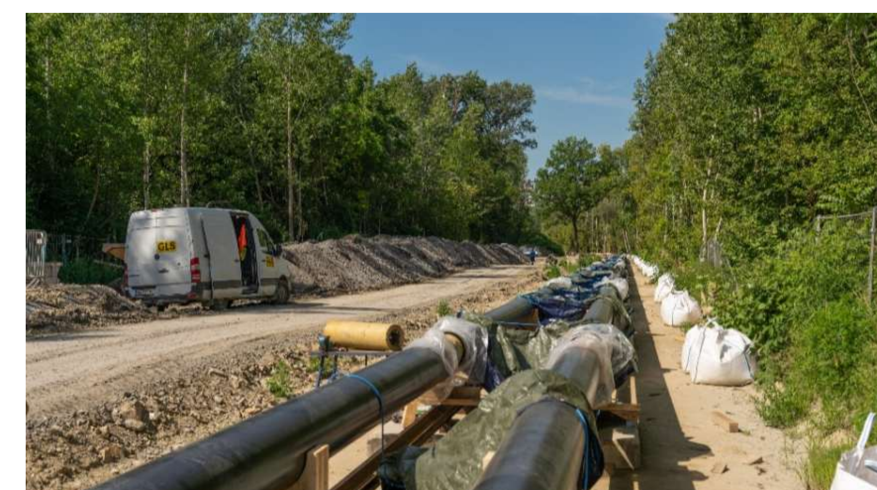
Die Rohrleitungen wurden über die Gesamtlänge von 460m am Standort verbunden...
