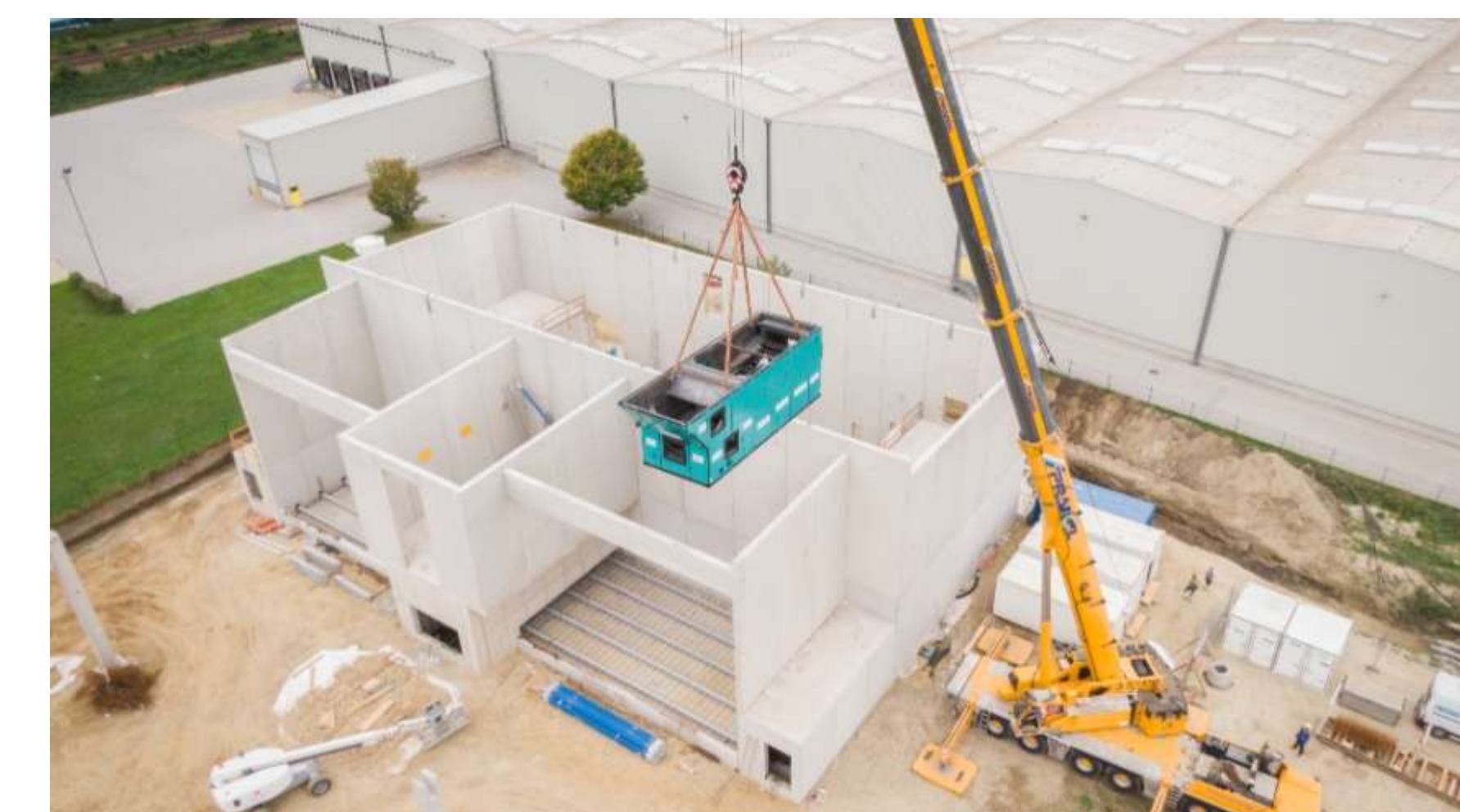
Neues Biomasseheizwerk in Spillern (Kesseleinhub)
