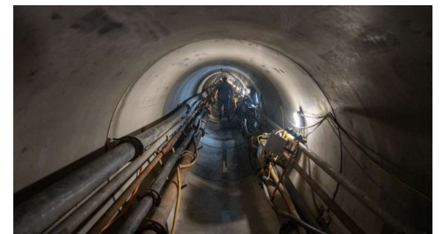
Der Tunnel hat einen Innendurchmesser von 2 m.
