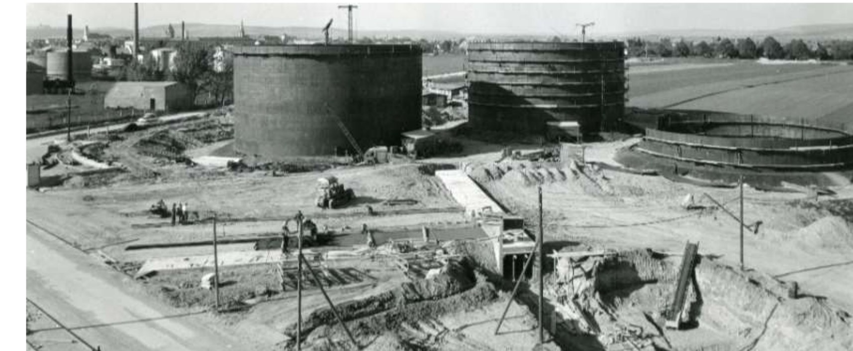
Schweröltanks, im Hintergrund links die Raffinerie Korneuburg (in Betrieb bis 1961)
