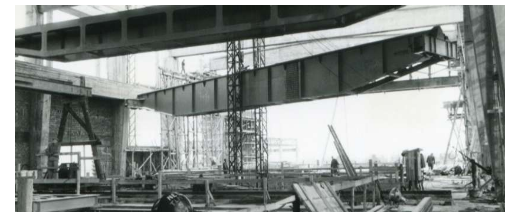
Montage des Brückenkrans in der Maschinenhalle (1959)
