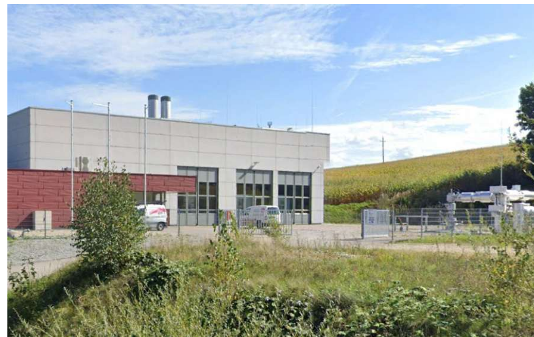
Geothermie-Anlage Ried im Innkreis (Energie Ried GmbH)
